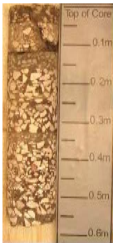
Rysunek 5. Pęknięcie góra-dół w grubej nawierzchni
