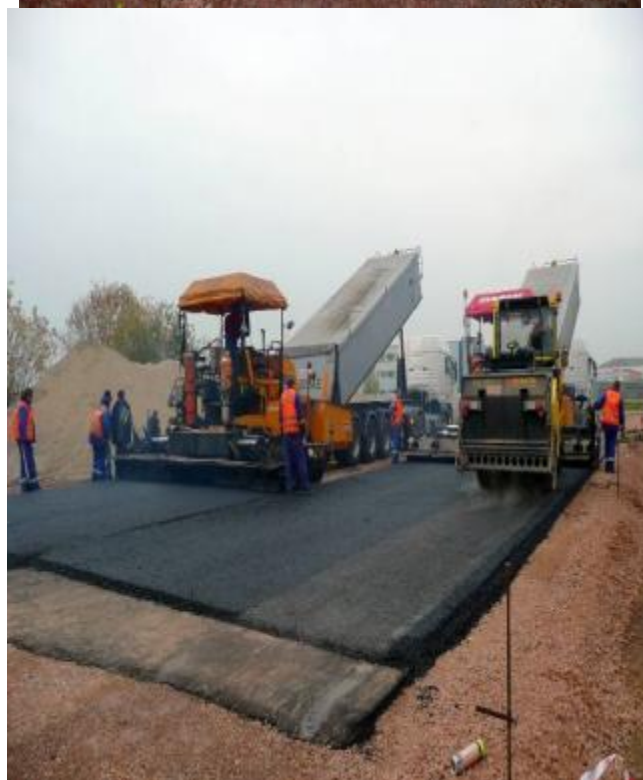
Fotografia 8 Prace przy wykonaniu oraz widok wykonanej warstwy wiążącej z AC WMS 16 20/30
