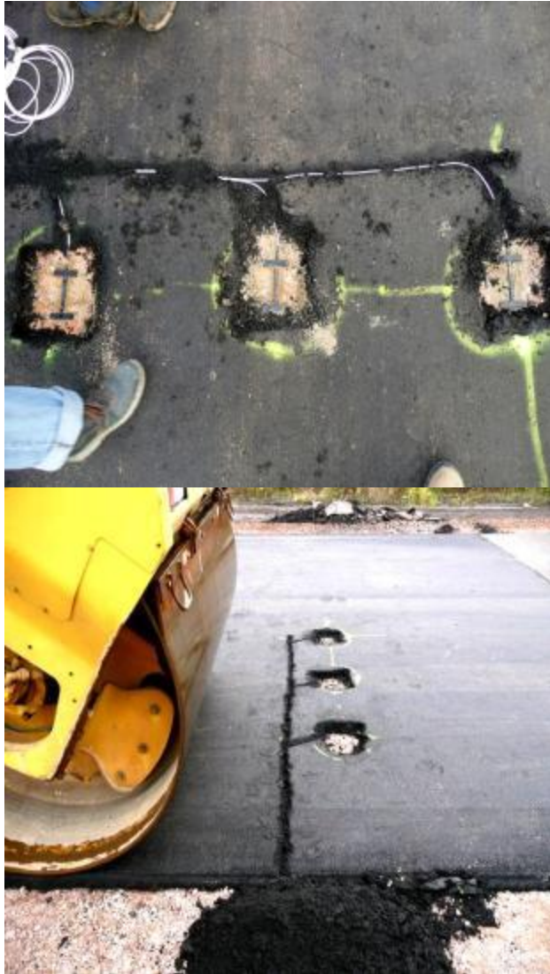
Fotografia 5 Instalowanie czujników (ACG) na warstwie podbudowy z kruszywa łamanego stabilizowanego mechanicznie
