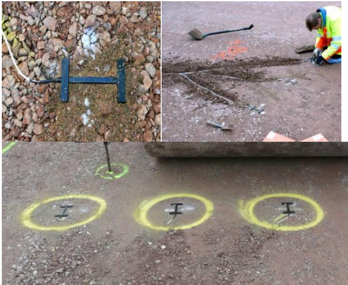
Fotografia 4 Instalowanie czujników (ACG) na warstwie podbudowy z kruszywa łamanego stabilizowanego mechanicznie
