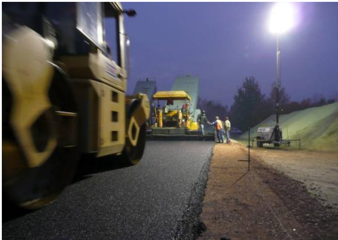
Fotografia 9 Prace przy wykonaniu oraz widok warstwy ścieralnej z mieszanki SMA8 DE80C
