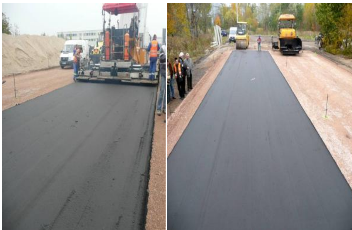
Fotografia 7 Widok wykonanej warstwy antyzmęgniowej
