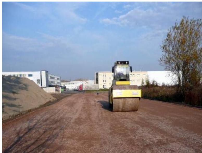
Fotografia 3 Wykonanie warstwy podbudowy z kruszywa łamanego stabilizowanego mechanicznie (kruszywo dolomitowe o uziarnieniu 0/31,5 mm)
